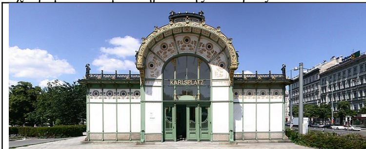
Η παλιά είσοδος του σταθμού στην πλατεία της Όπερας
